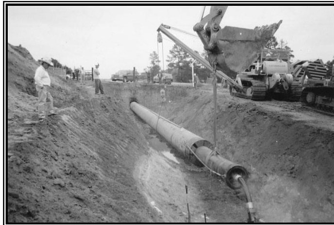
Gráfico 20: Hincado de Tuberías
